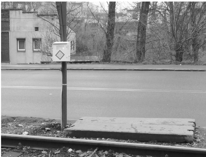
Rys. 2. Skrzynka ręcznej sygnalizacji mijankowej na ul. Obrońców Westerplatte w Katowicach foto. Hubert Kleban
